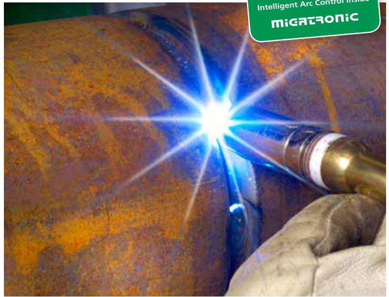
IAC™ – gyökvarratok függőlegesen lefelé hegesztése egy távfűtőcsőben. A hegesztési sebesség lényegesen nagyobb, mint a hagyományos, felfelé hegesztés esetén.
